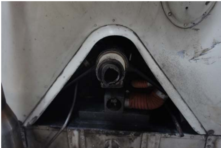
Fotografía No. 14 El conjunto del amortiguador se encontró comprimido en su totalidad. (Vástago o candela completamente adentro del cuerpo del amortiguador).
